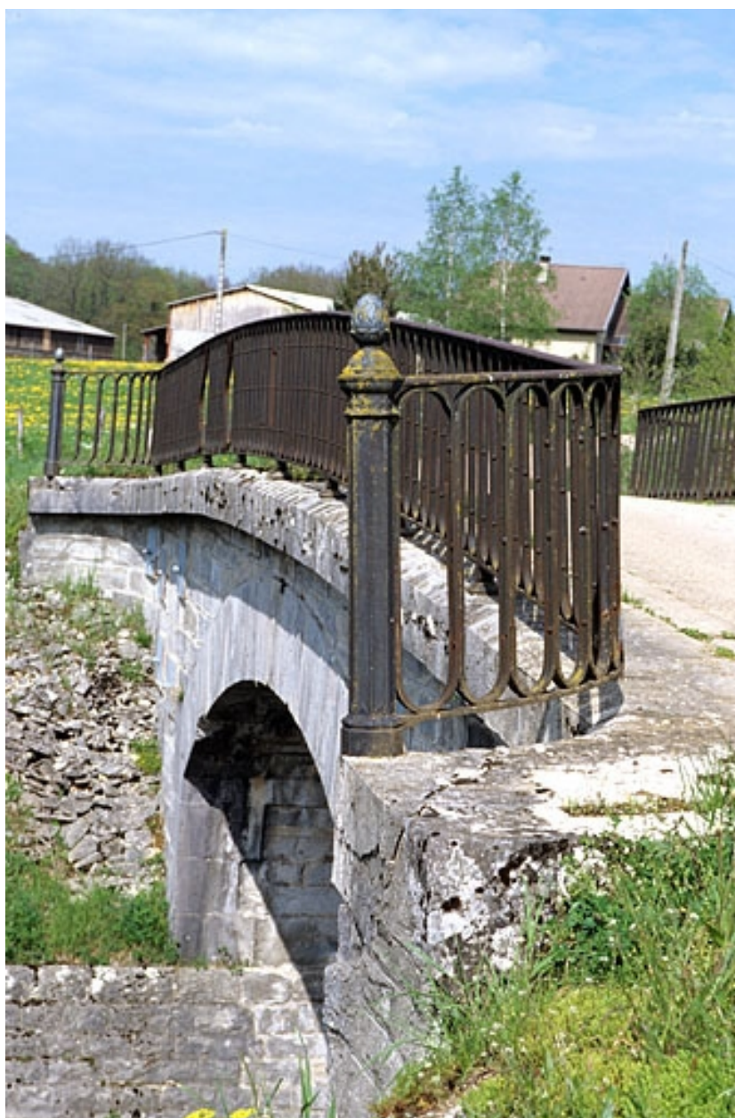
Vue d'ensemble du garde-corps nord.
