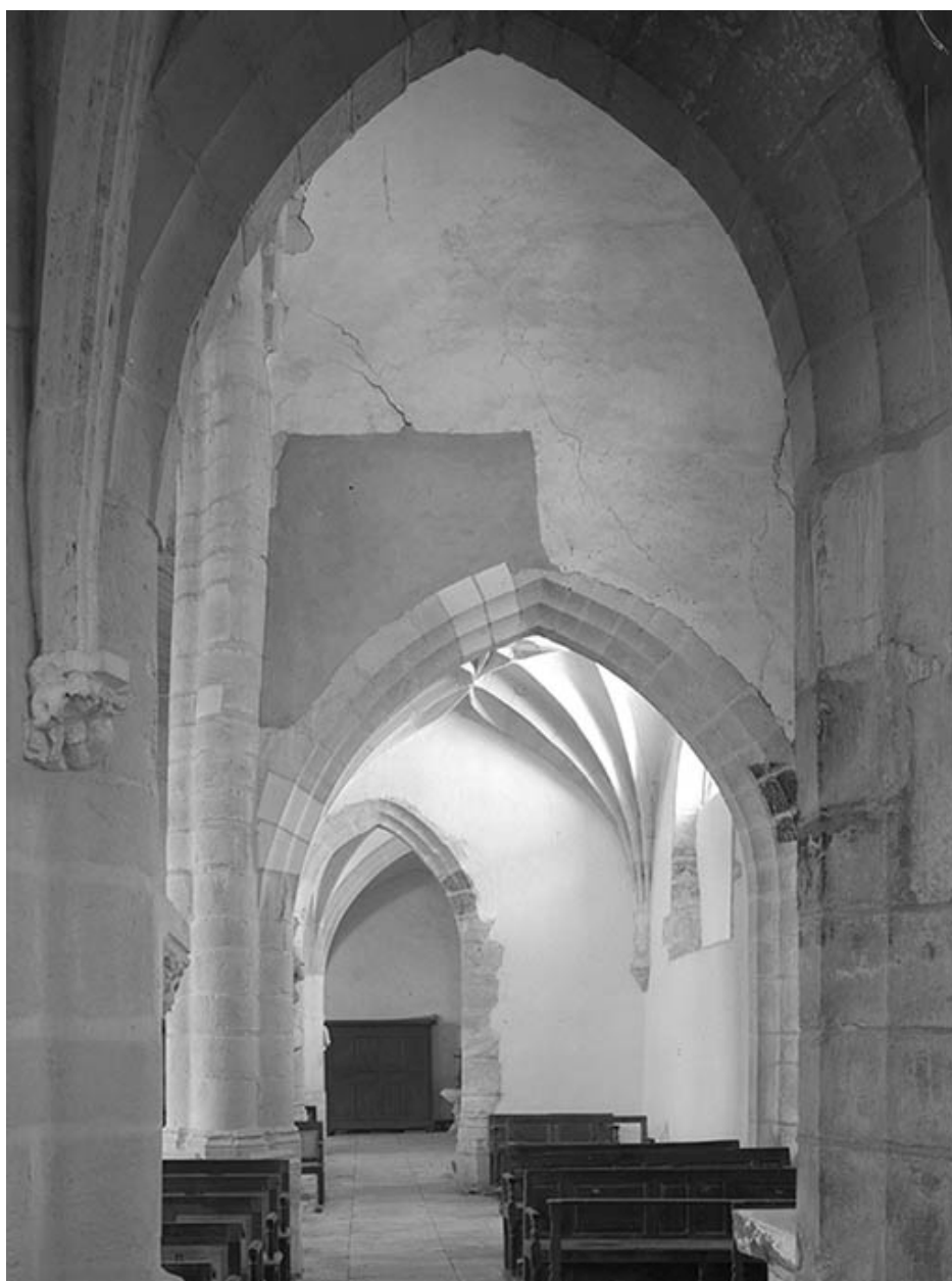
Collatéral gauche, vue depuis le mur postérieur.
