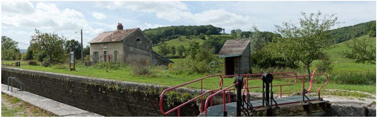
Vue d'ensemble du site d'écluse.
