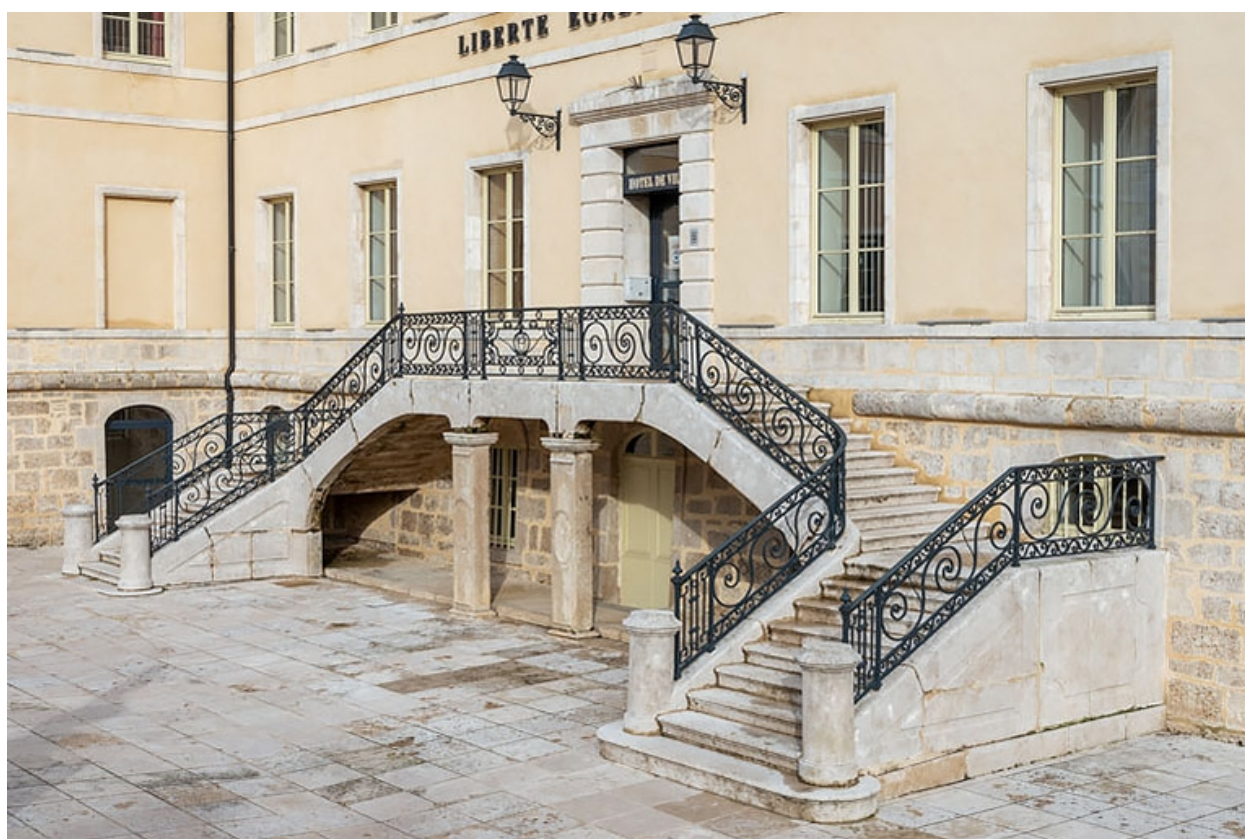
Aile est, façade antérieure : escalier.
