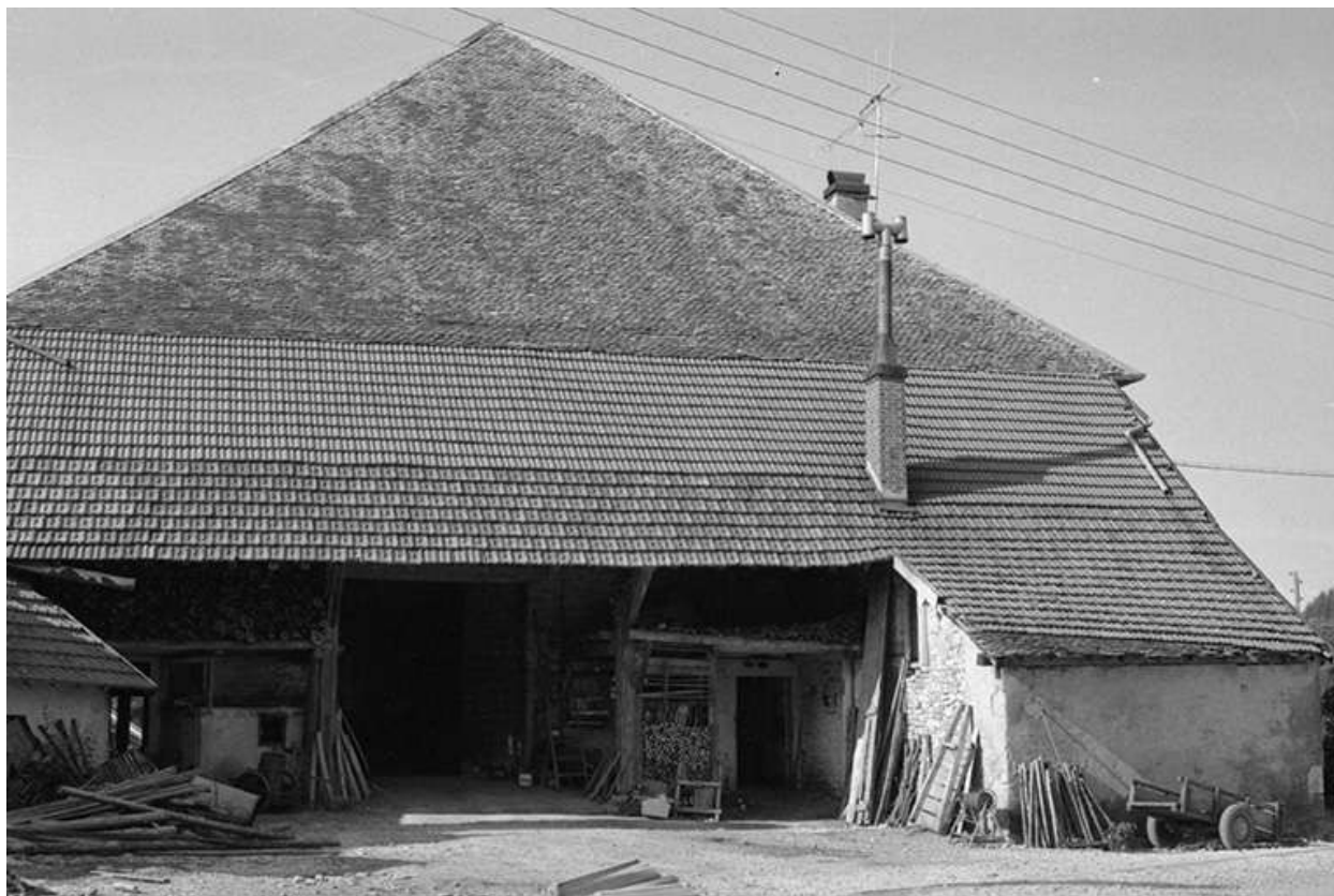
Façade latérale gauche.
