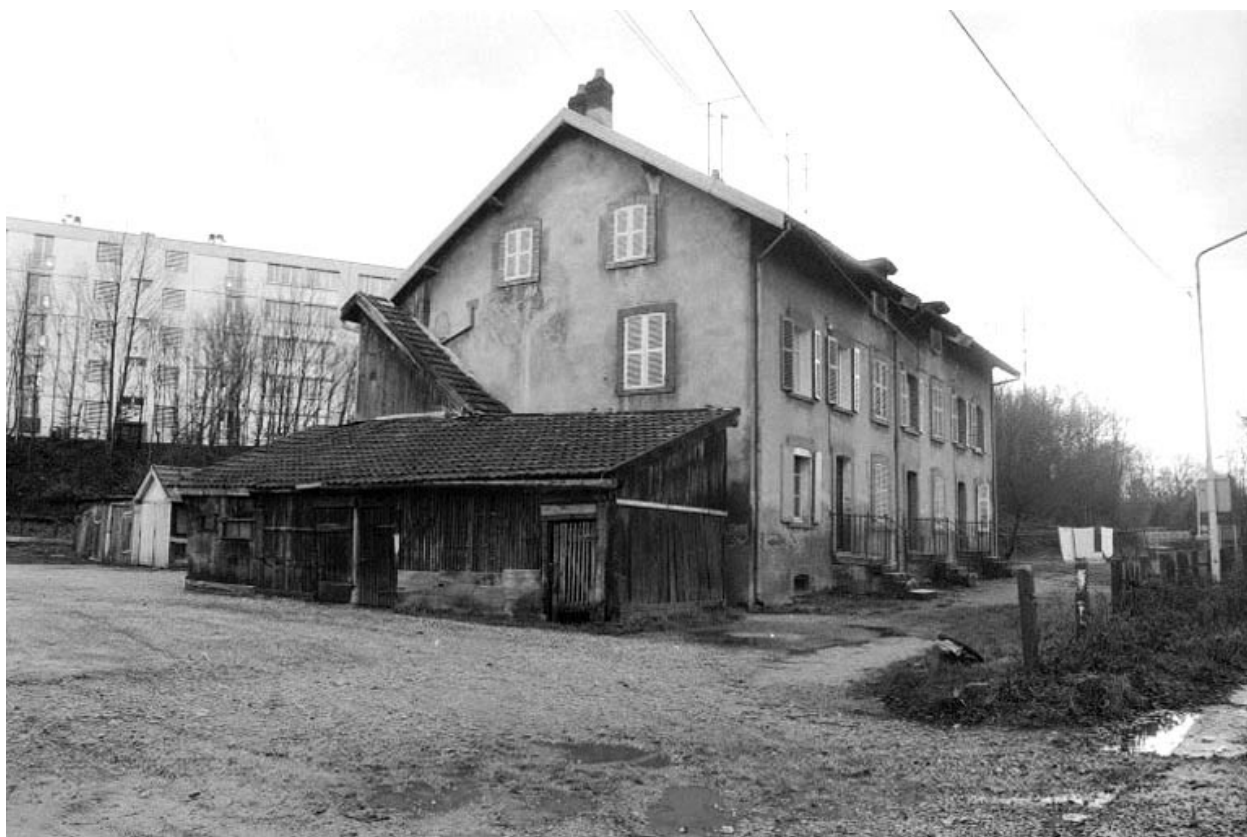
Façades antérieure et latérale gauche.
