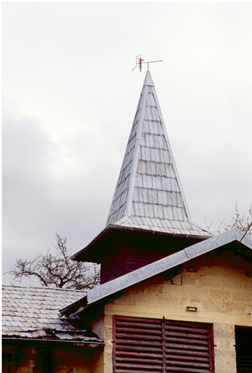
Remise d'automobile et bûcher (F) : flèche couverte de tuiles métalliques.
