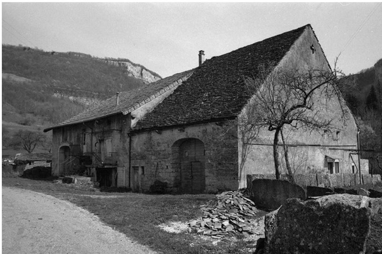
Ferme située rue du Chalet.
