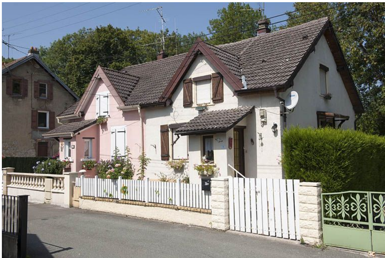
Maison jumelée rue des Campenottes.
