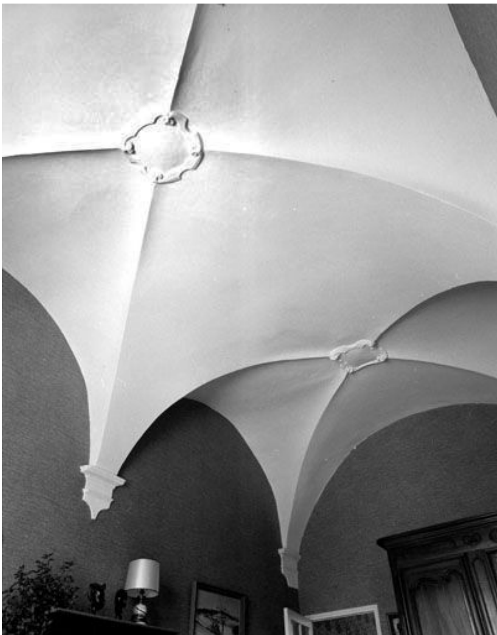
La voûte de la chapelle.
