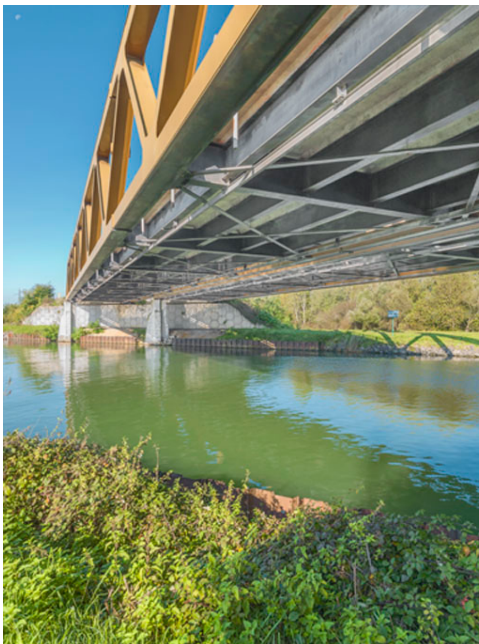
Le tablier du pont.
