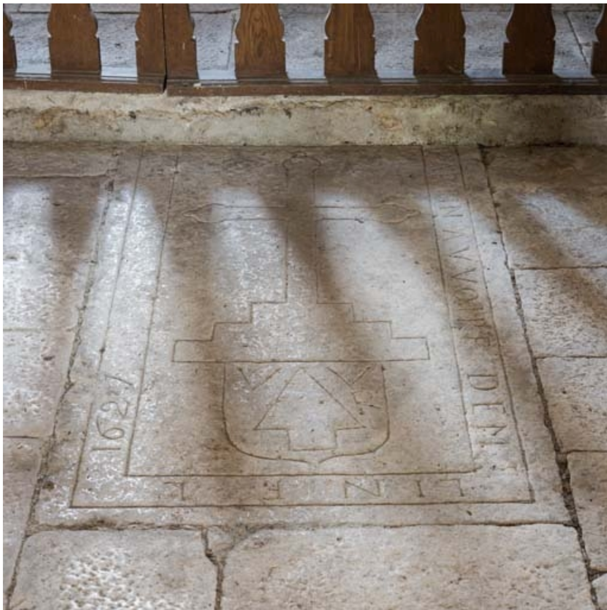
Vue d'ensemble de la dalle 4.
