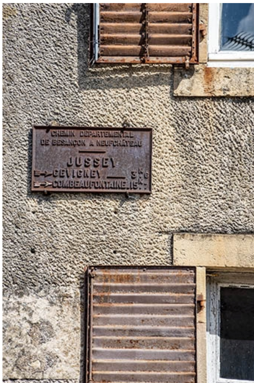
Détail de la façade avec plaque directionnelle.
