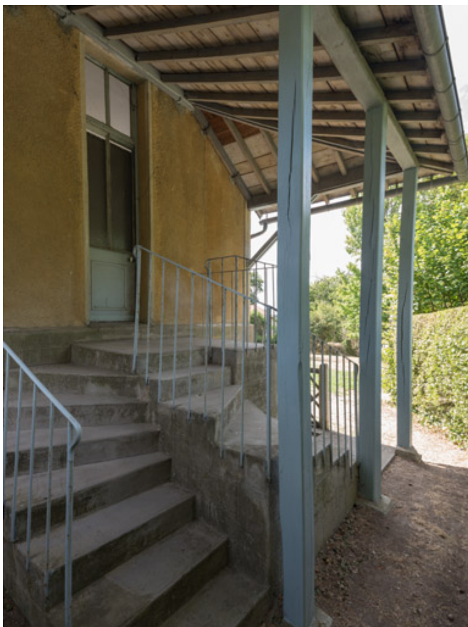
Entrée latérale, côté nord.
