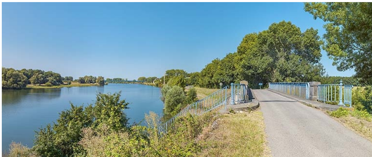
Le pont sur la Dheune, vu d'amont.
