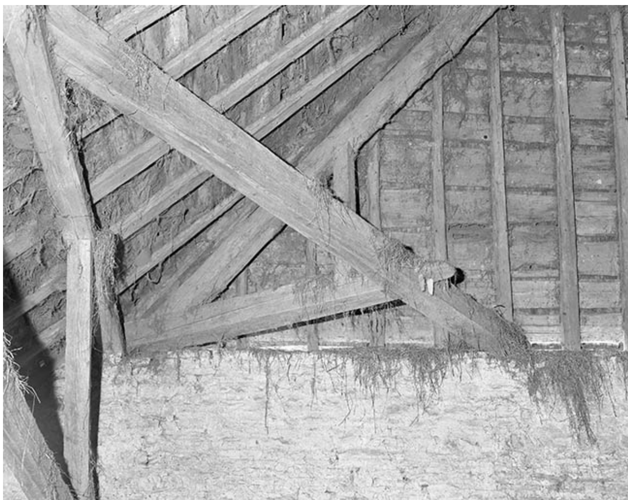
Détail de la charpente au niveau d'une demi-croupe.
