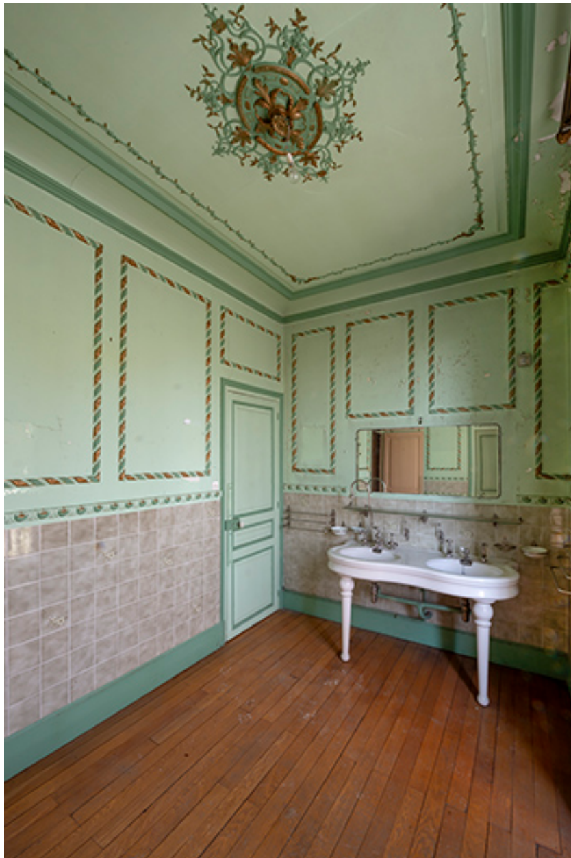
Premier étage, salle d'eau.
