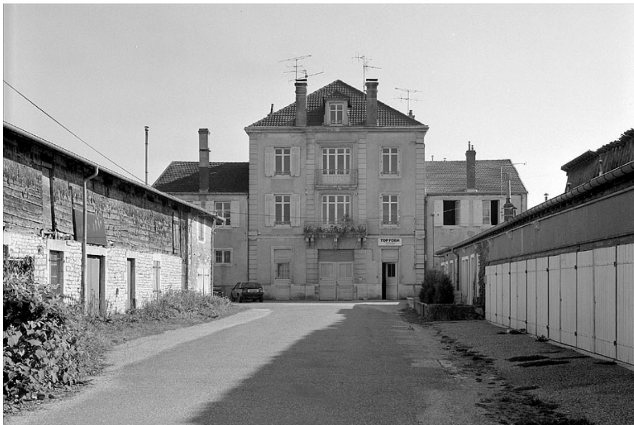
Vue d'ensemble de l'habitation, de face.
