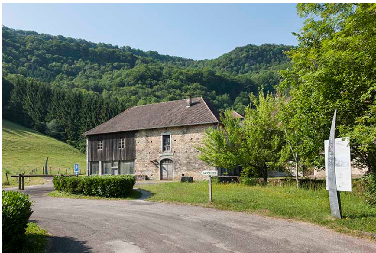
Atelier de fabrication vu depuis le nord.
