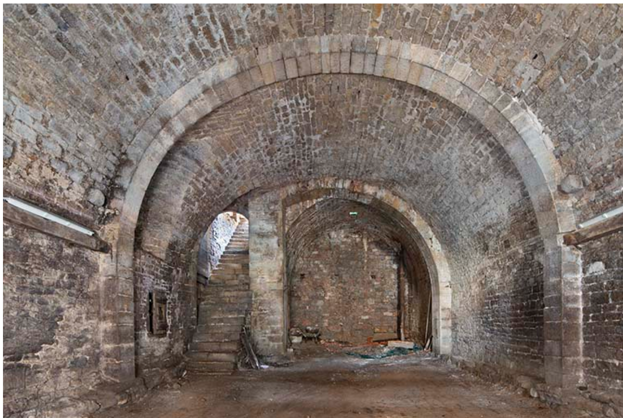
Cave : vue depuis l'ouest.
