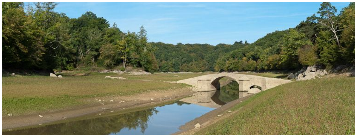
Vue du pont.
