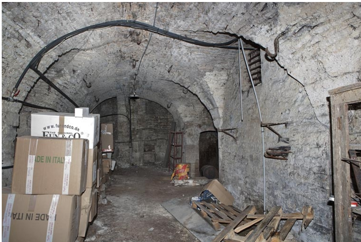
Logis principal, sous-sol : cave A depuis l'entrée.
