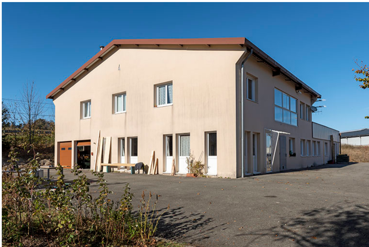
Façades antérieure et latérale gauche.
