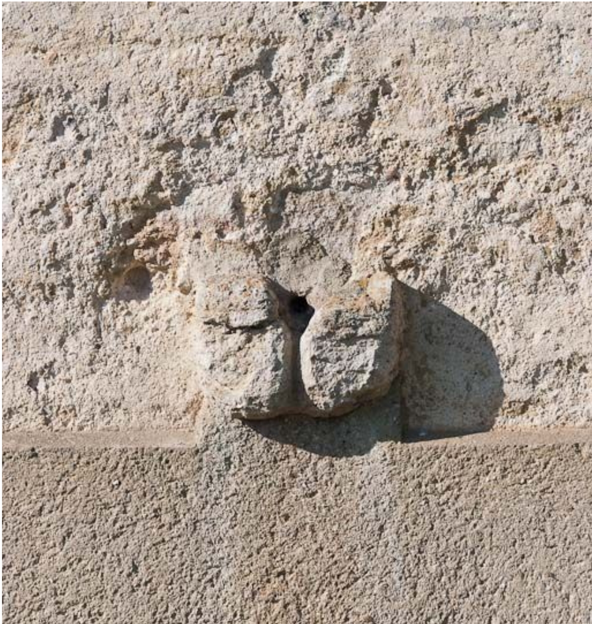
Vue d'une pierre d'écoulement de l'évier.
