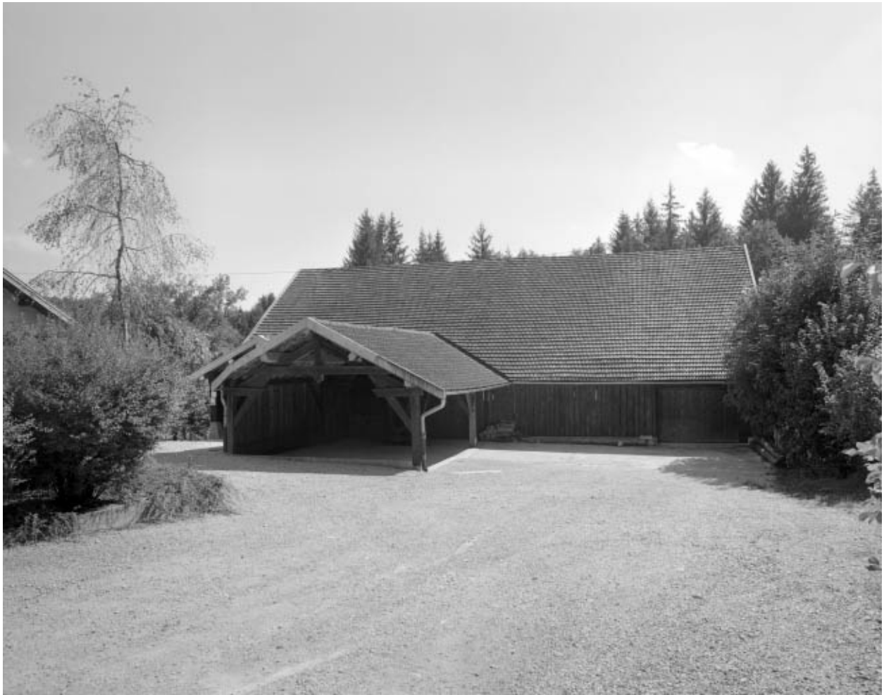
Façade nord de l'atelier de fabrication.
