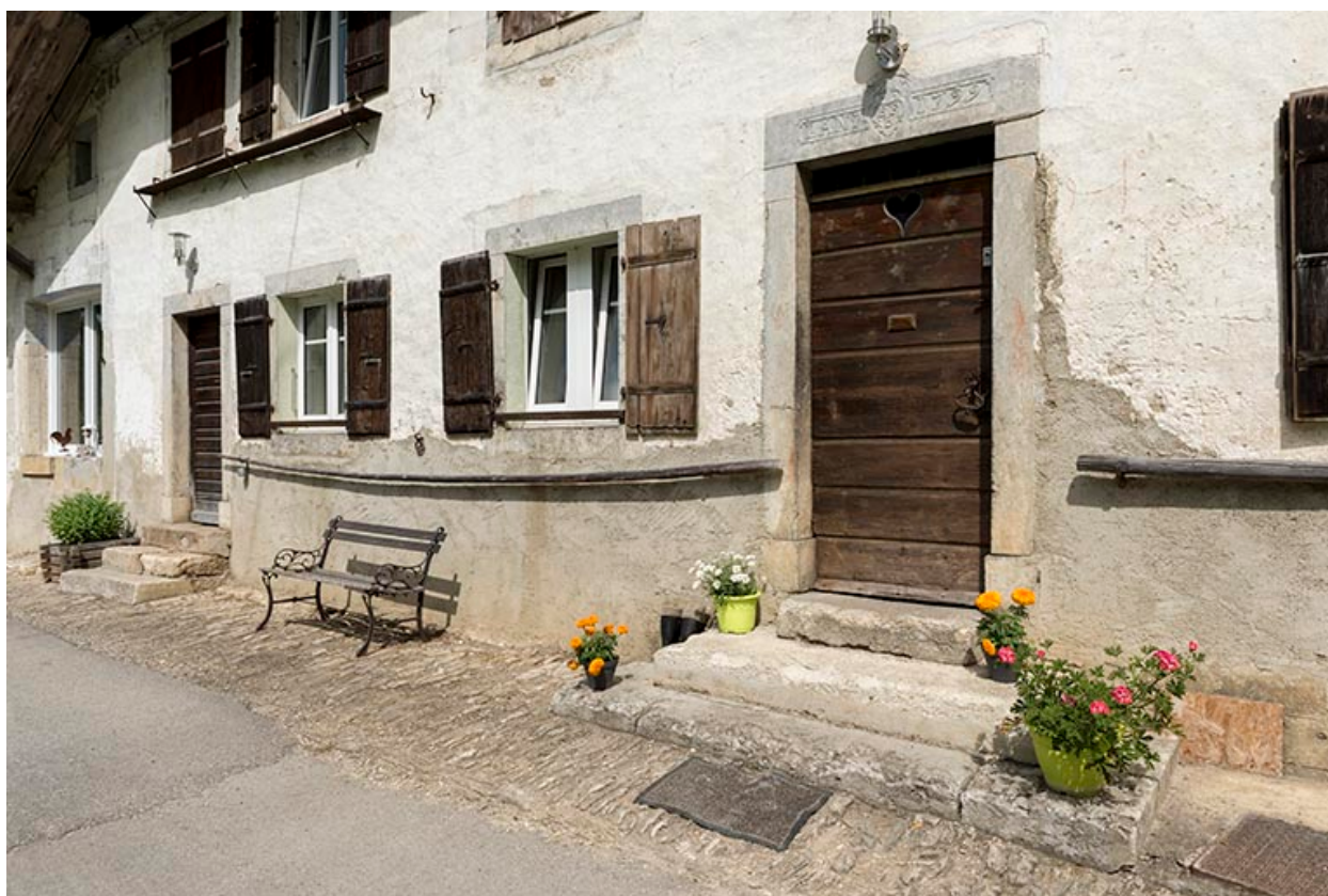
Façade antérieure : portes et fenêtres au rez-de-chaussée.
