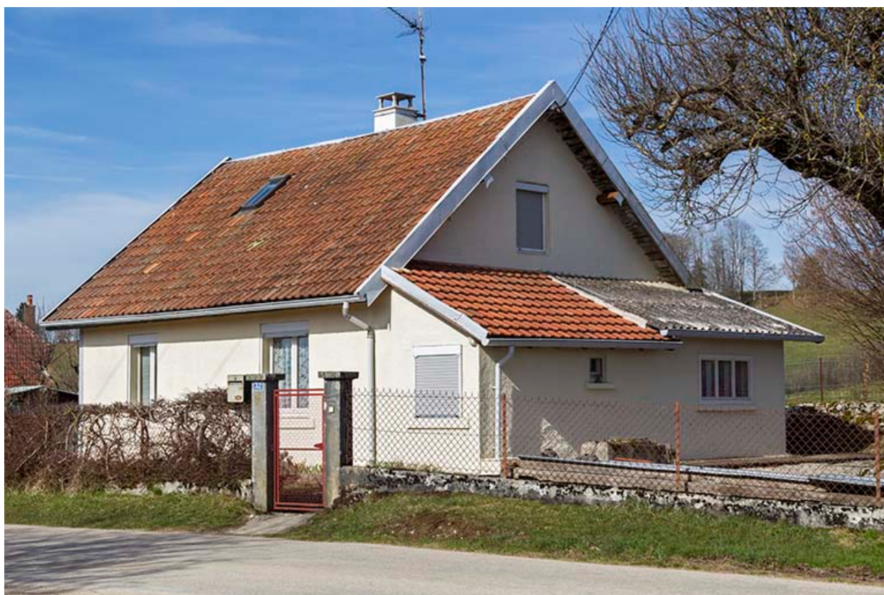
Façades antérieure et latérale droite.
