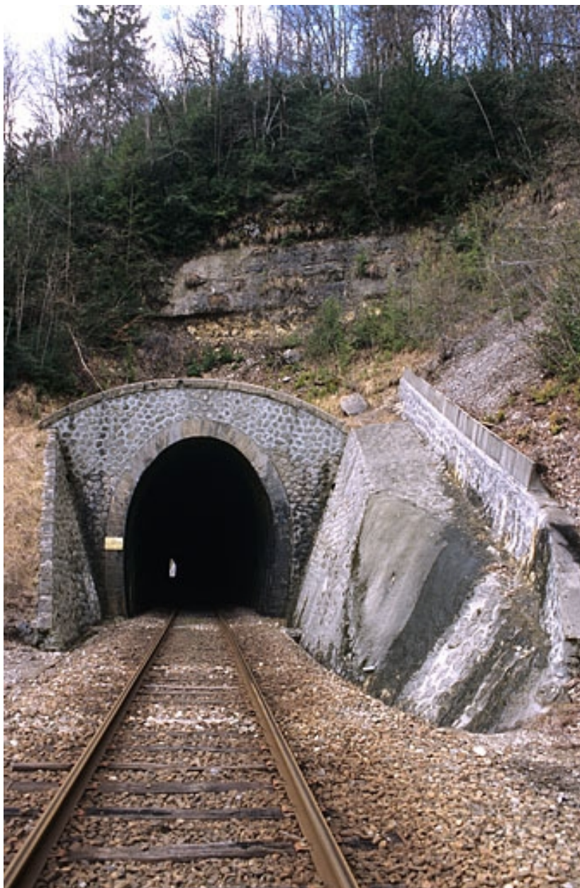
Tunnel des Frettes : tête côté Andelot-en-Montagne (nord).
