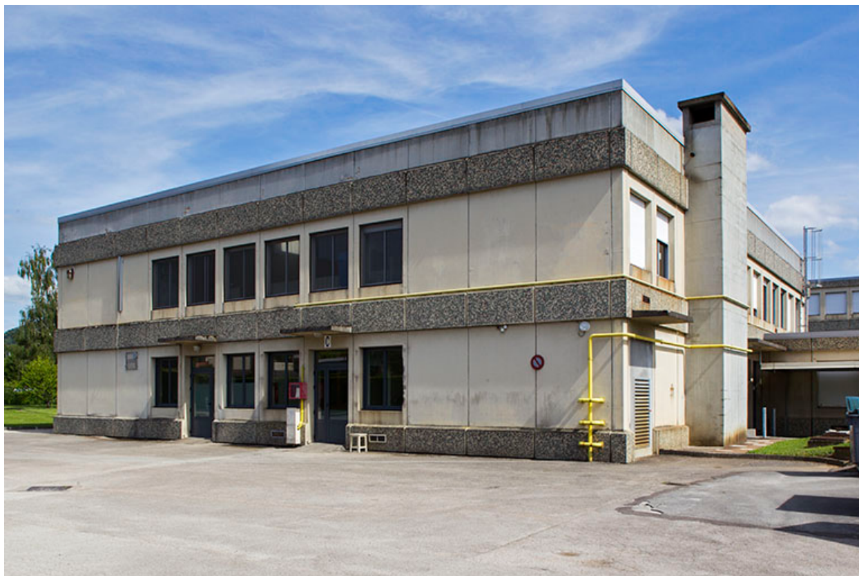
Façade nord du bâtiment de restauration.
