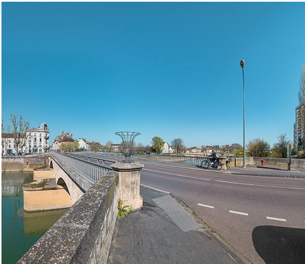
Vue d'ensemble du pont depuis la chaussée.
