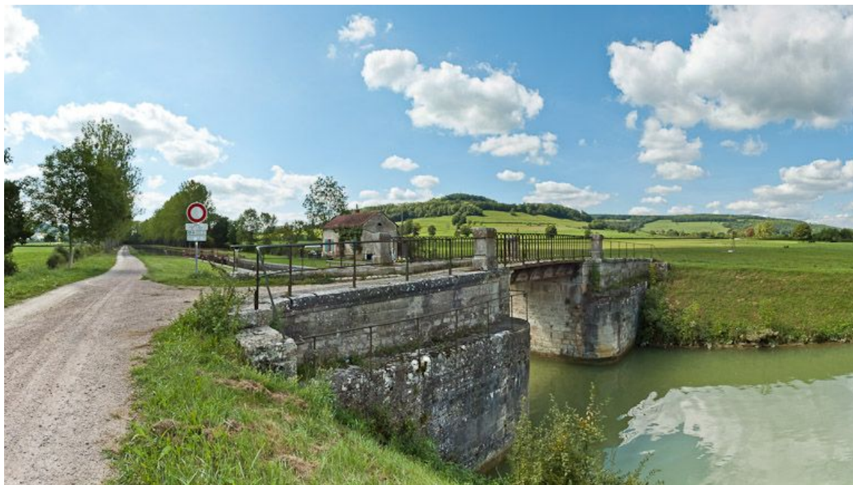
Vue du pont.
