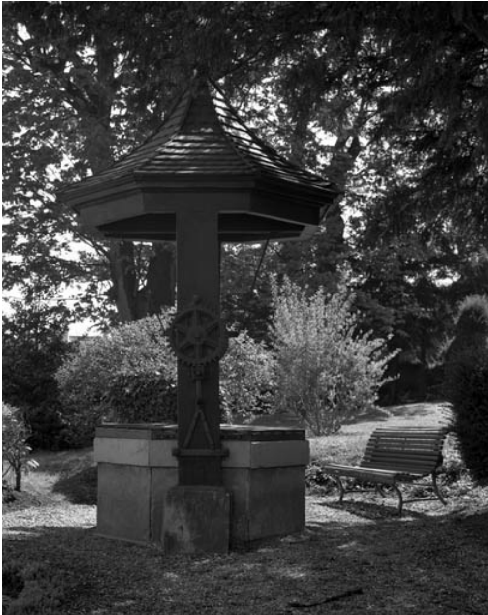
Vue d'ensemble du puits.
