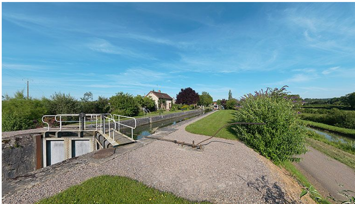
Vue d'ensemble prise d'aval.
