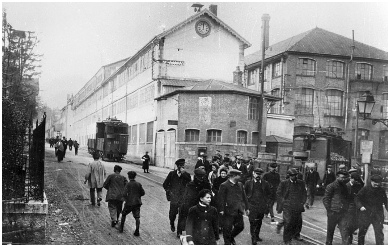
L'usine des Fonteneilles.
