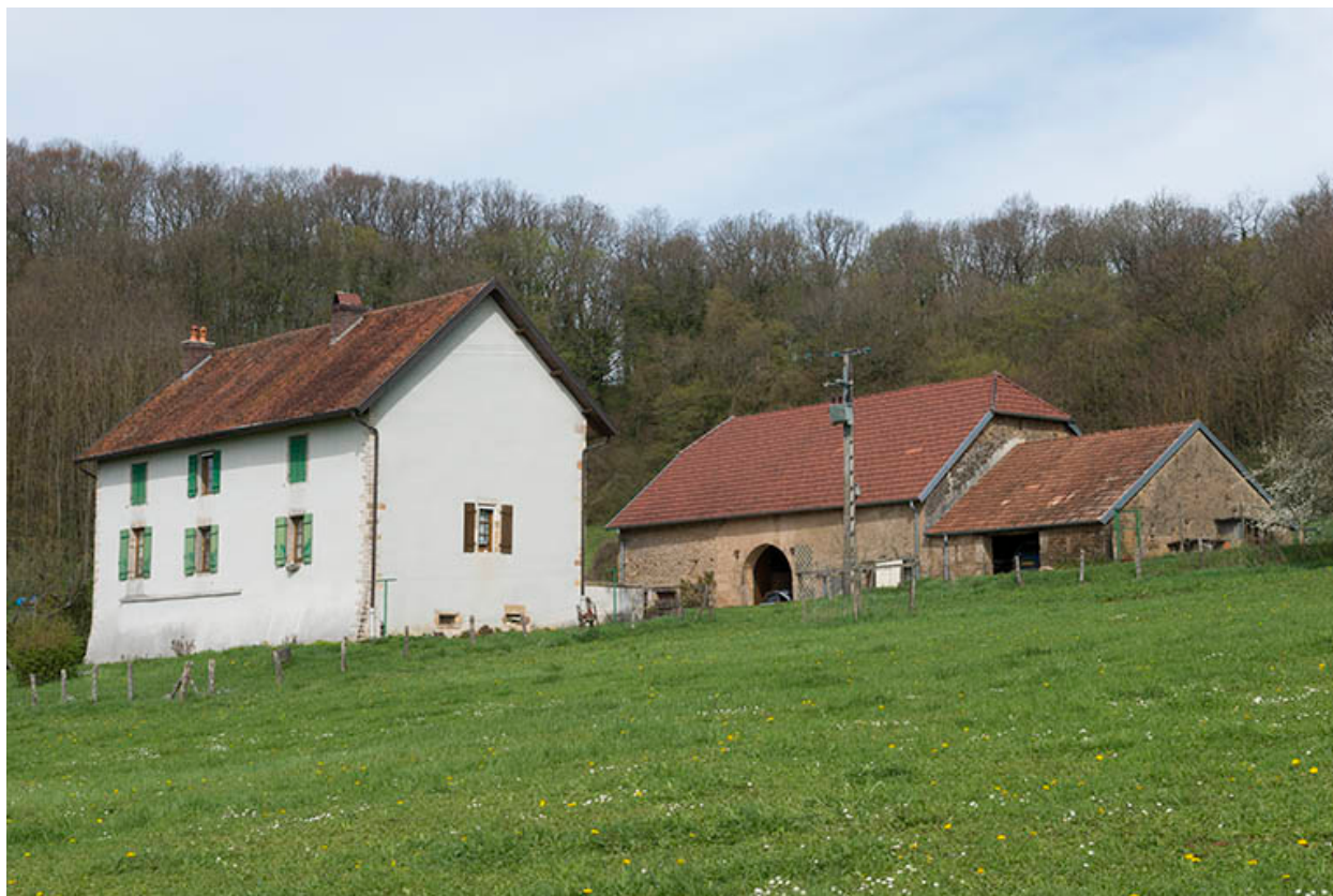
Vue générale des bâtiments composant le site.
