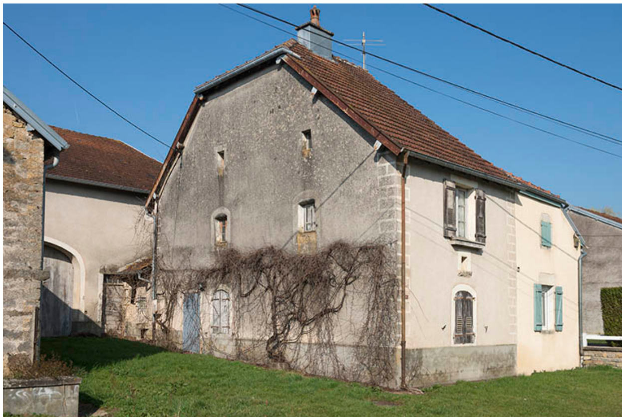
Vue sur l'usoir et la partie habitation.
