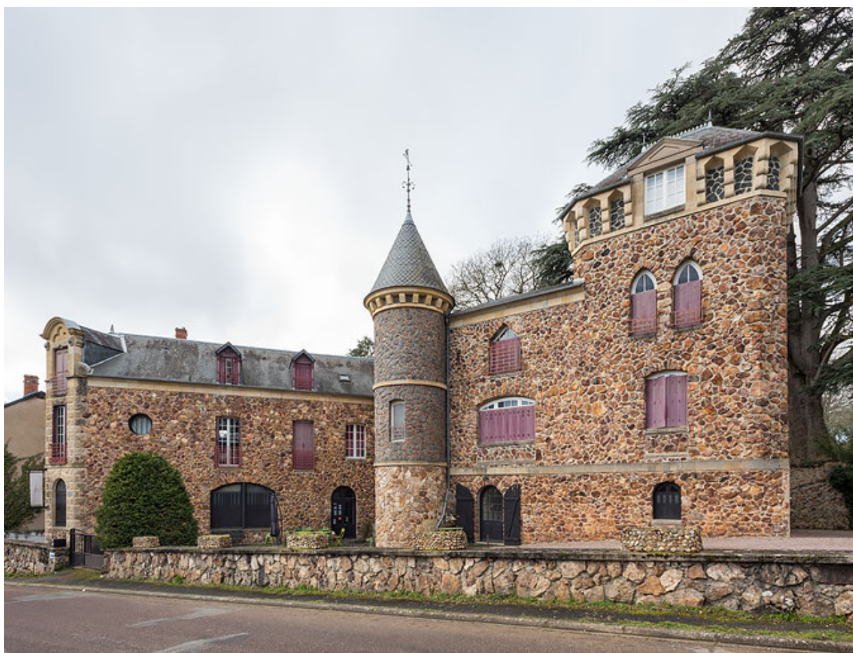
Façade sur la rue de L'Hâte.
