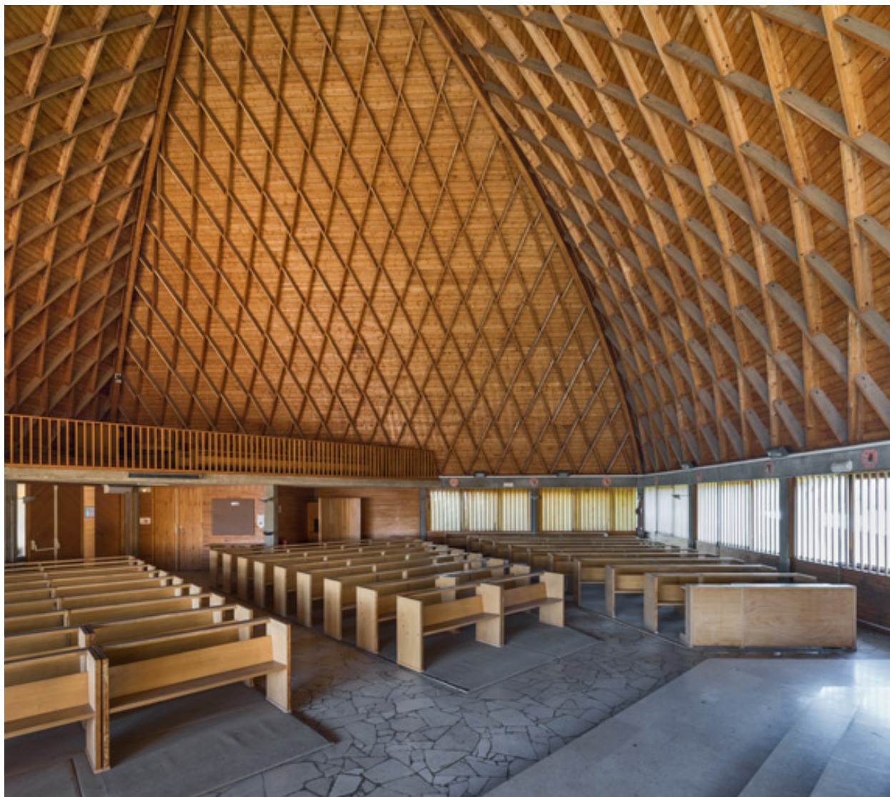
Nef. Vue en direction du nord-ouest.
