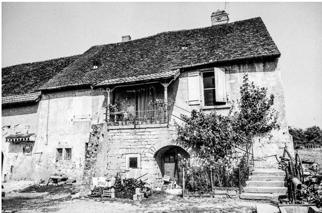
Façade antérieure : vue rapprochée.
