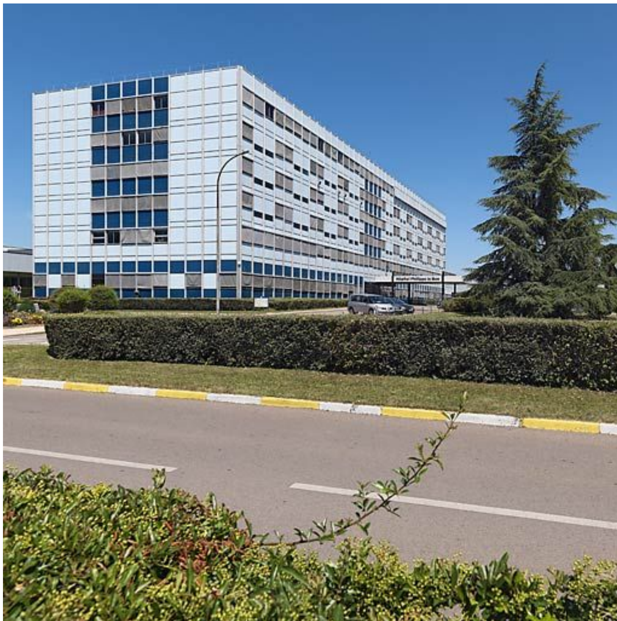
Bâtiment principal, vue d'ensemble de trois-quarts.
