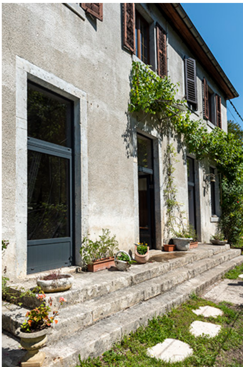
Façade antérieure et perron, vus en enfilade.
