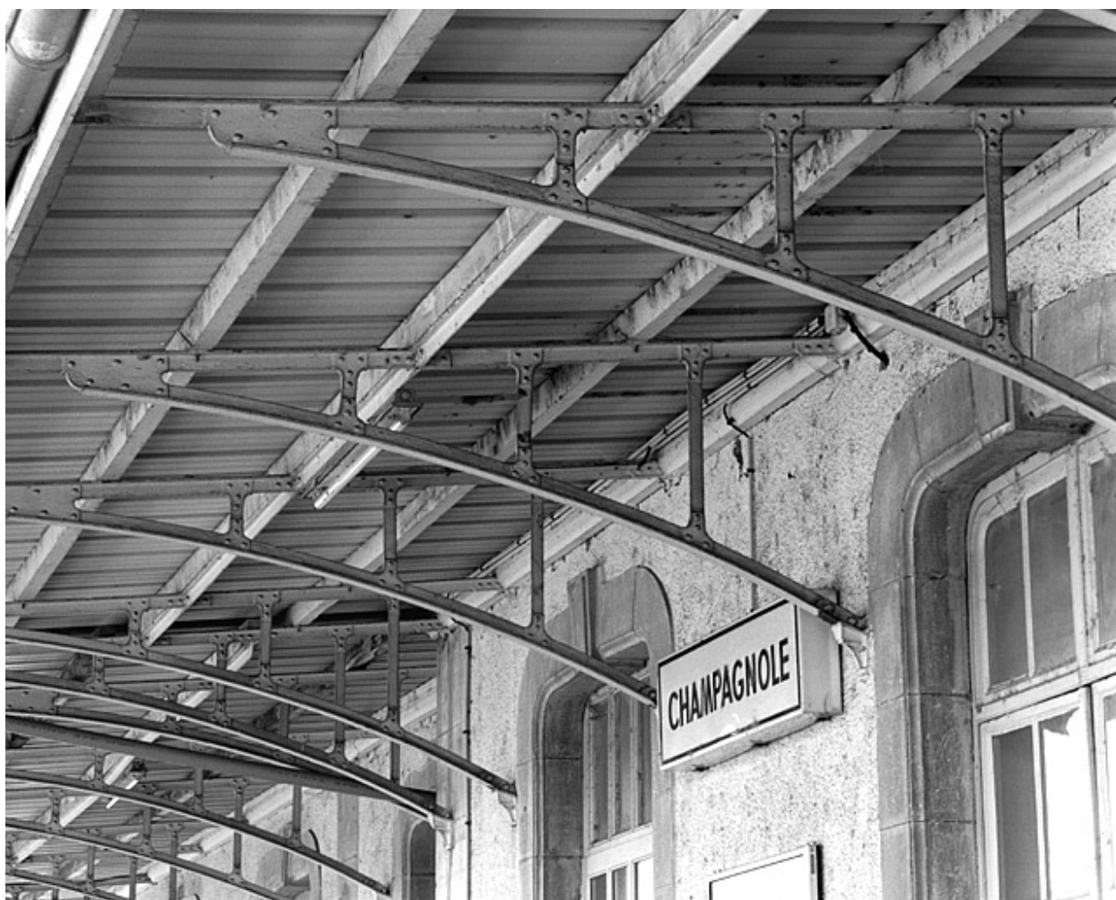
Bâtiment des voyageurs : consoles métalliques soutenant l'auvent.
