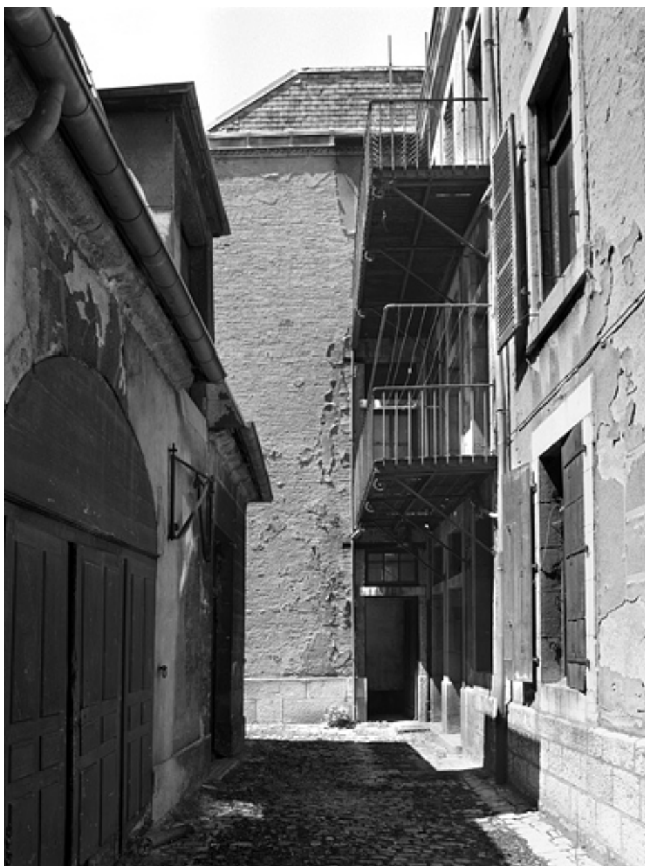
Logis secondaire droit : façade latérale gauche.
