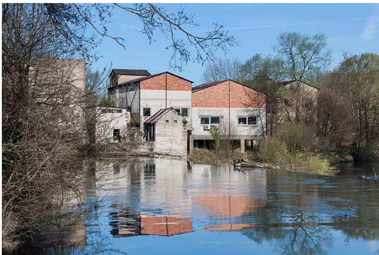
Vue d'ensemble depuis l'amont du barrage.
