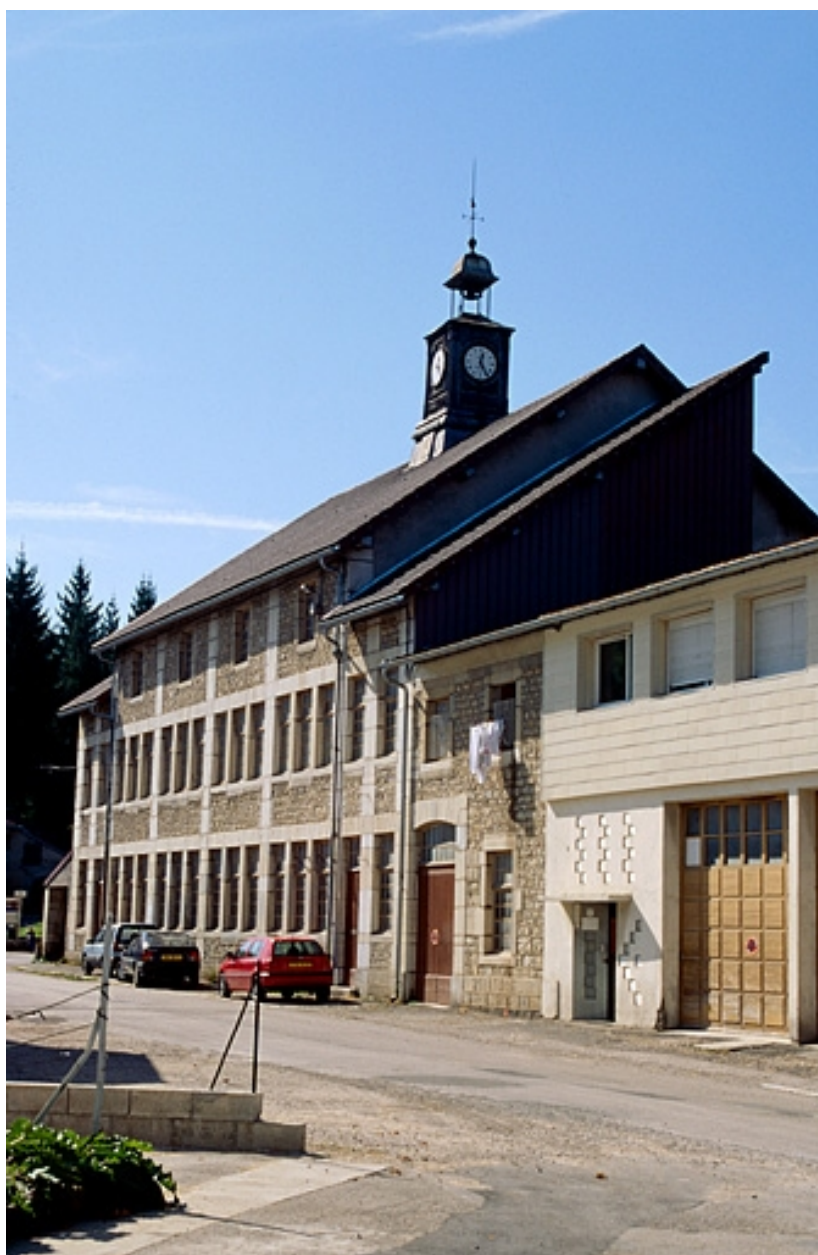
Façade antérieure de l'atelier de fabrication.
