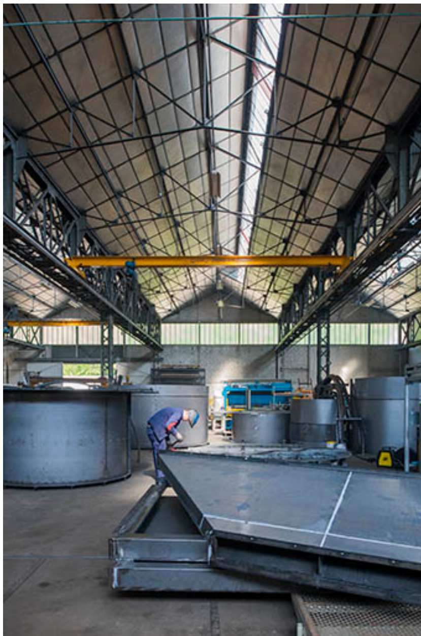
Travée de l'atelier de laminage.
