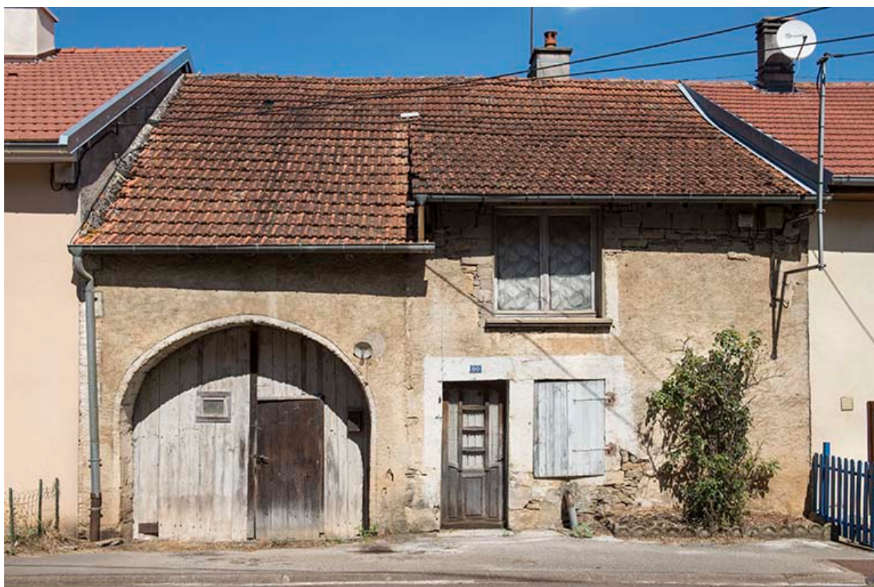
Ferme-bloc à deux travées.
