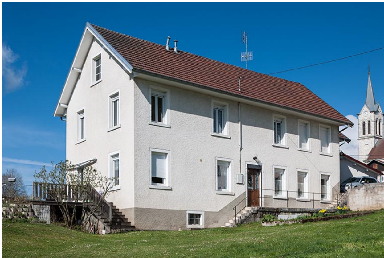
Atelier : façade antérieure, de trois quarts gauche.
