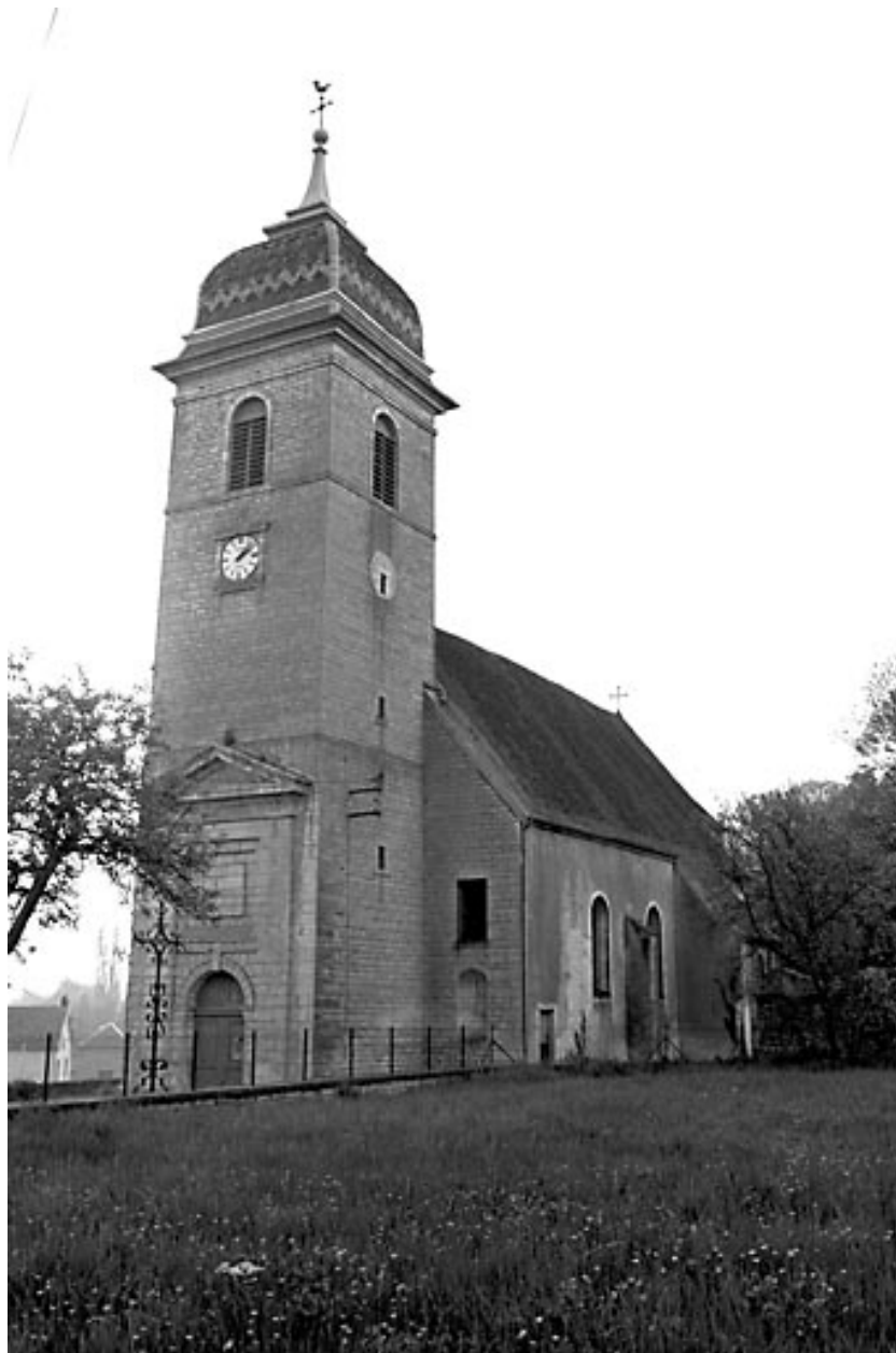
Vue d'ensemble : clocher-porche et façade latérale droite.
