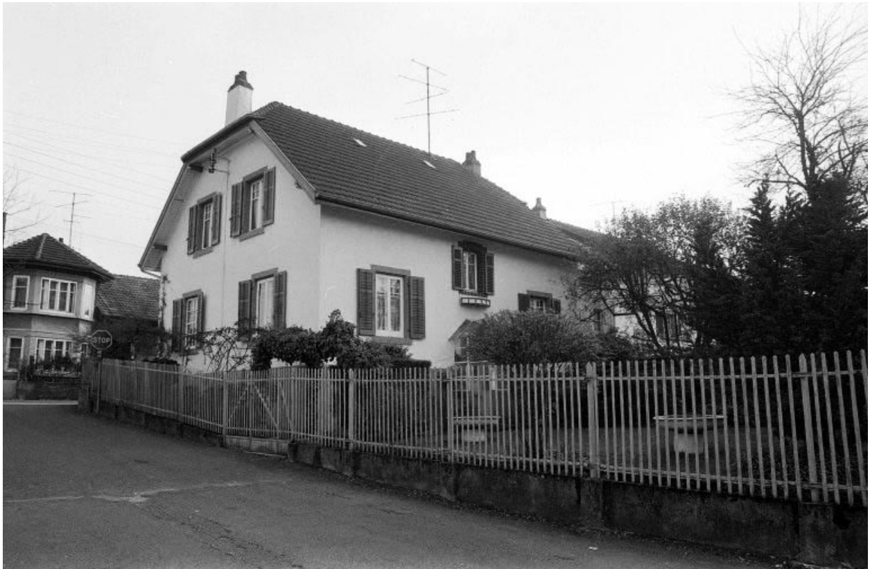
Façades postérieure et latérale droite.
